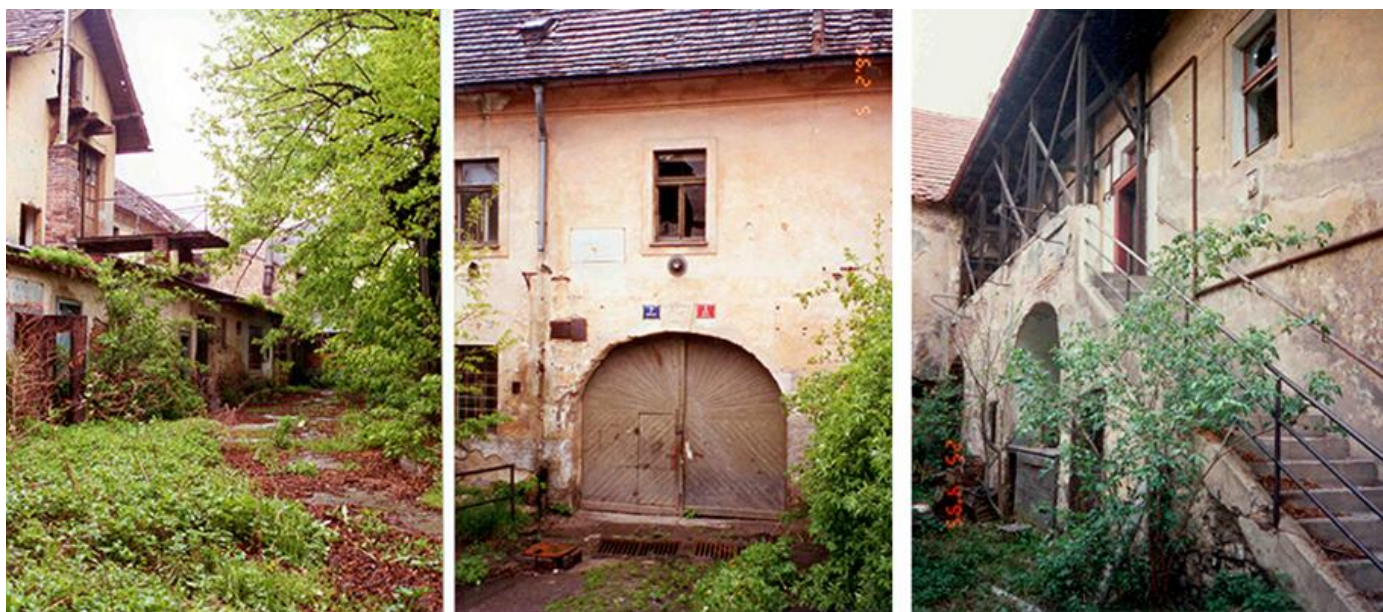
Stav schátralého objektu Michelského dvora před rekonstrukcí
