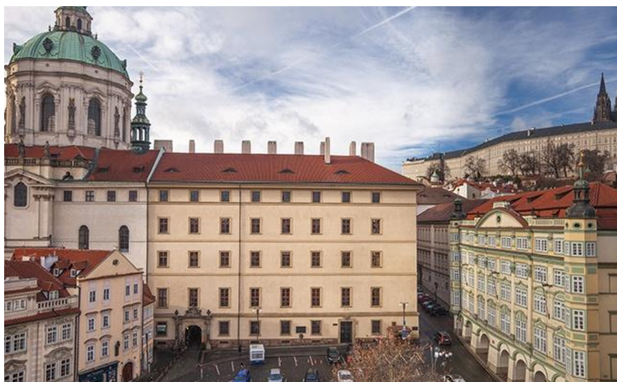
Pohled na východní část Profesního domu. Vpravo je vstup do budovy MFF, vlevo za portálem s pilastry vjezd do dvora a vchod do stejnojmenné restaurace Zdroj:[3]
